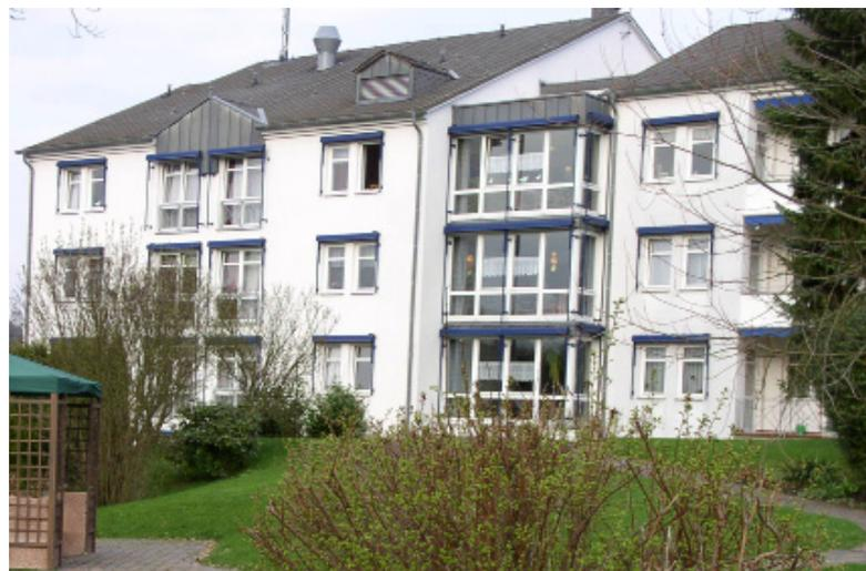
soll auch der Algenbefall an der Südfassade behoben werden. Dafür muss die Fassade mit einem Dampfgerät abgestrahlt und ein spezieller Schutzanstrich aufgetragen werden.
